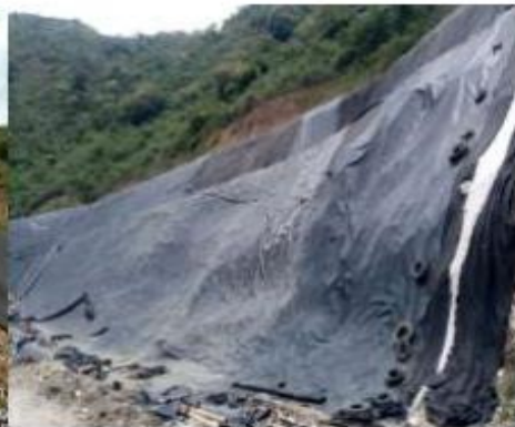
Imagen 22 y 23. Instalación de Geomembrana.
