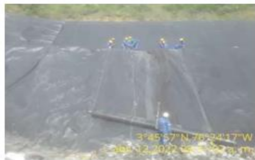
Imagen 22 y 23. Instalación de Geomembrana.
