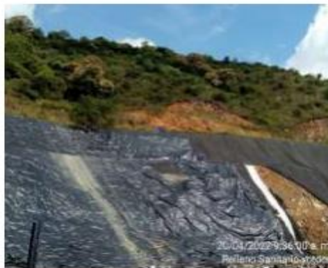
Imagen 22 y 23. Instalación de Geomembrana.
